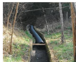
Section en tuyau canal du Tourrel, travaux réalisés en 2012.
